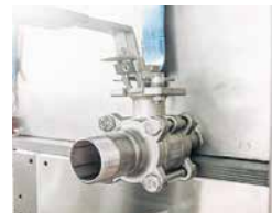
Schwäbische Spezialitäten: Bei Aluca lässt sich aus Aluminium alles Erdenkliche nach Sonderwunsch einrichten. So werden auch Tanks an Bord individuell ausgerichtet und bearbeitet – im Bild ein angeschweißter Hahn am Tank.
