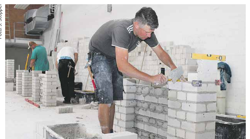
Ralf Behrends aus Wiesmoor zieht während seiner Situationsaufgabe eine Mauer hoch. Er hat diesen Teil der Prüfung als Bester bestanden.
