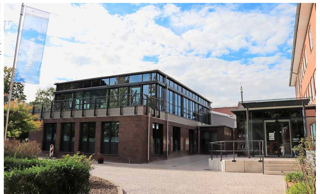
Bald sind auch die letzten Feinarbeiten am neuen Gebäude sowie dem neuen Eingangsbereich der Handwerkskammer in der Straße des Handwerks abgeschlossen.
